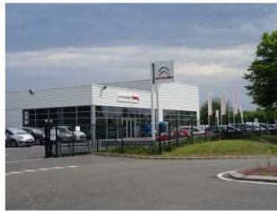
Sur façade et scellées au sol
